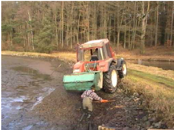
Befestigte Einfahrt in den Teich
