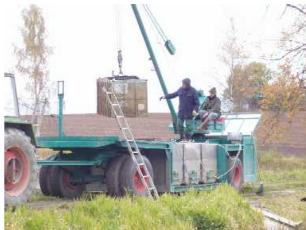
Tieflader mit Transportbehälter und Kran
