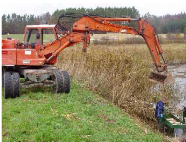
Radbagger mit Fischkorb
