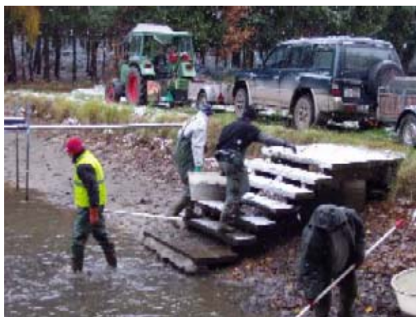
Treppe zur Abfischgrube
